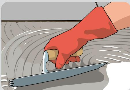
По понятным причинам, чтобы добиться смачивания плитки, зубцы шпателя по размерам должны соответствовать формату плитки.
